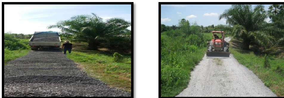
โครงการปรับปรุงถนนสายชุมชนพัฒนา ๒ หมู่ที่ ๖
