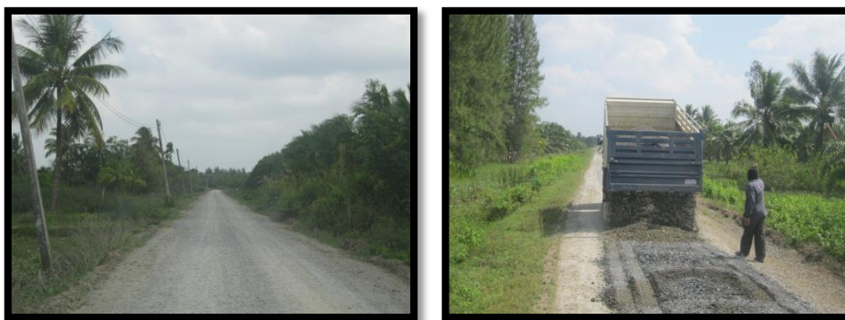
โครงการปรับปรุงถนนสายบางลิบบาท-บางปอหนองเสม็ด หมู่ที่ ๙
